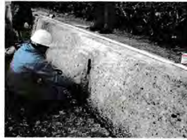
プライマー塗布
