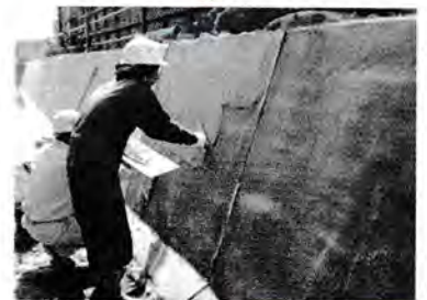
上塗モルタル塗布
