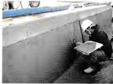
下塗モルタル塗布
