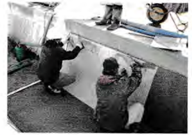
耐アルカリガラス繊維ネット敷設
